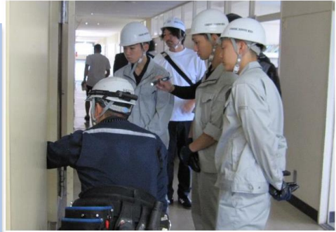
外部講師の指導によるエアコン用電源増設工事実習の様子
