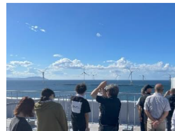
【洋上風力発電施設の見学】
