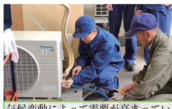
気候変動によって需要が高まっているエアコンの据付について学びます。
