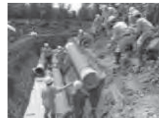
地下熱利用の配管埋設
