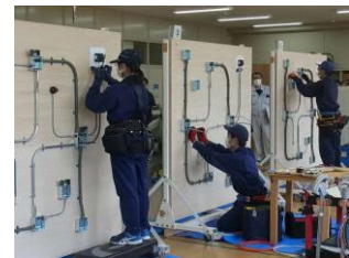
【電気工事部門】
