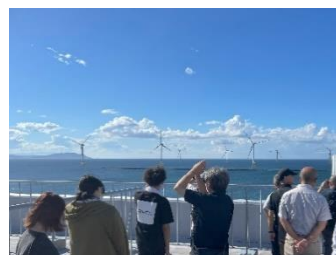
【洋上風力発電施設の見学】
