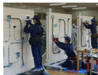
【電気工事部門】
