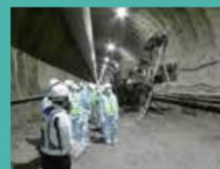
新幹線トンネル工事の見学 (札幌工業高校)
